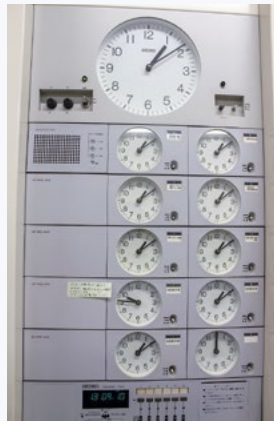
院内の時計も 管理しています▶
