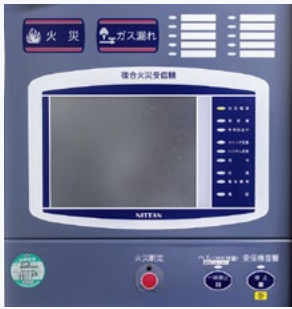
▲火災、ガスの警報機
