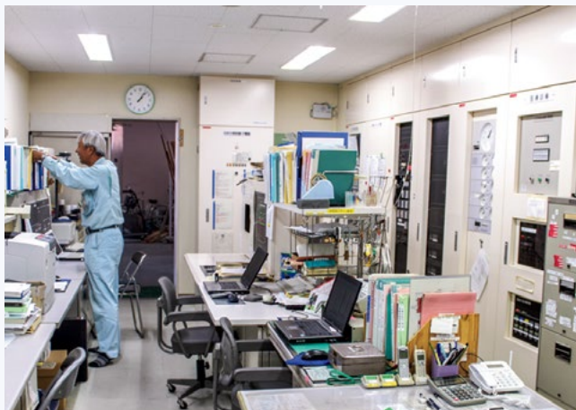
中央監視室の内部
