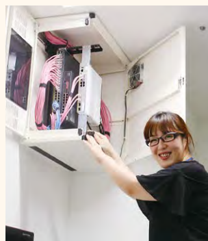
回線のトラブルを 点検しています
