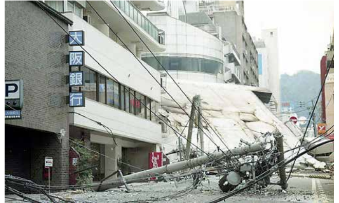
写真12：倒壊したビル 倒壊や倒壊を免れたビルからのコンクリートやタイルの落下、倒壊した電信柱から地表に垂れた電線など危険がいっぱいでした。(*2) http://kobe117shinsai.jp/area/chuo/c020.php
