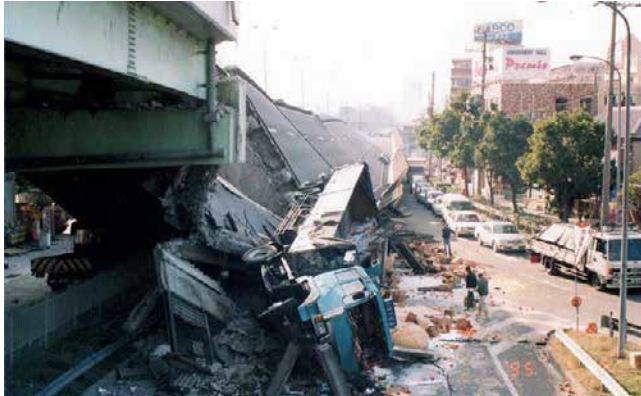
写真11：倒れた高速道路 倒れた高速道路から転落した車。橋桁の下敷きになった車も多くありました。(*2) http://kobe117shinsai.jp/category/cat13/j-b1.php
